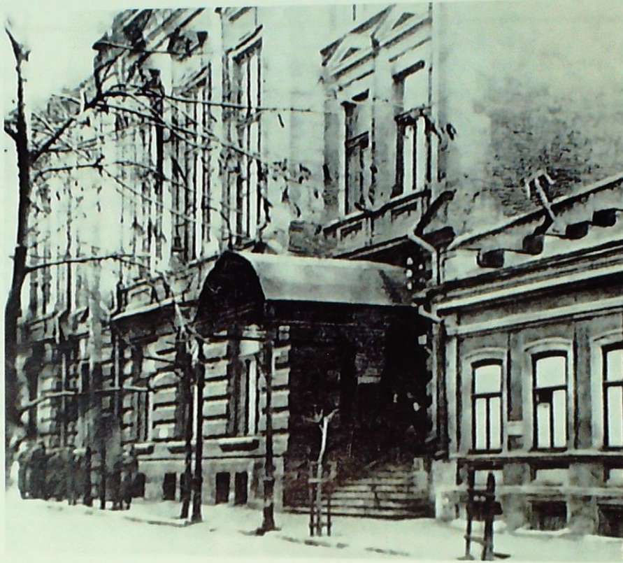
Здание, в котором проходил 1-й съезд Советов ДСР Ростов-на-Дону. Апрель 1918 г. ГАРО. Фотокаталог
